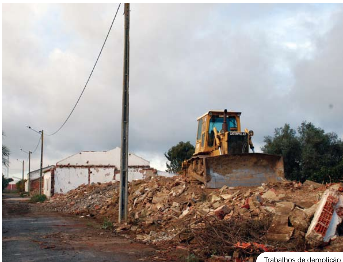
Trabalhos de demolição
